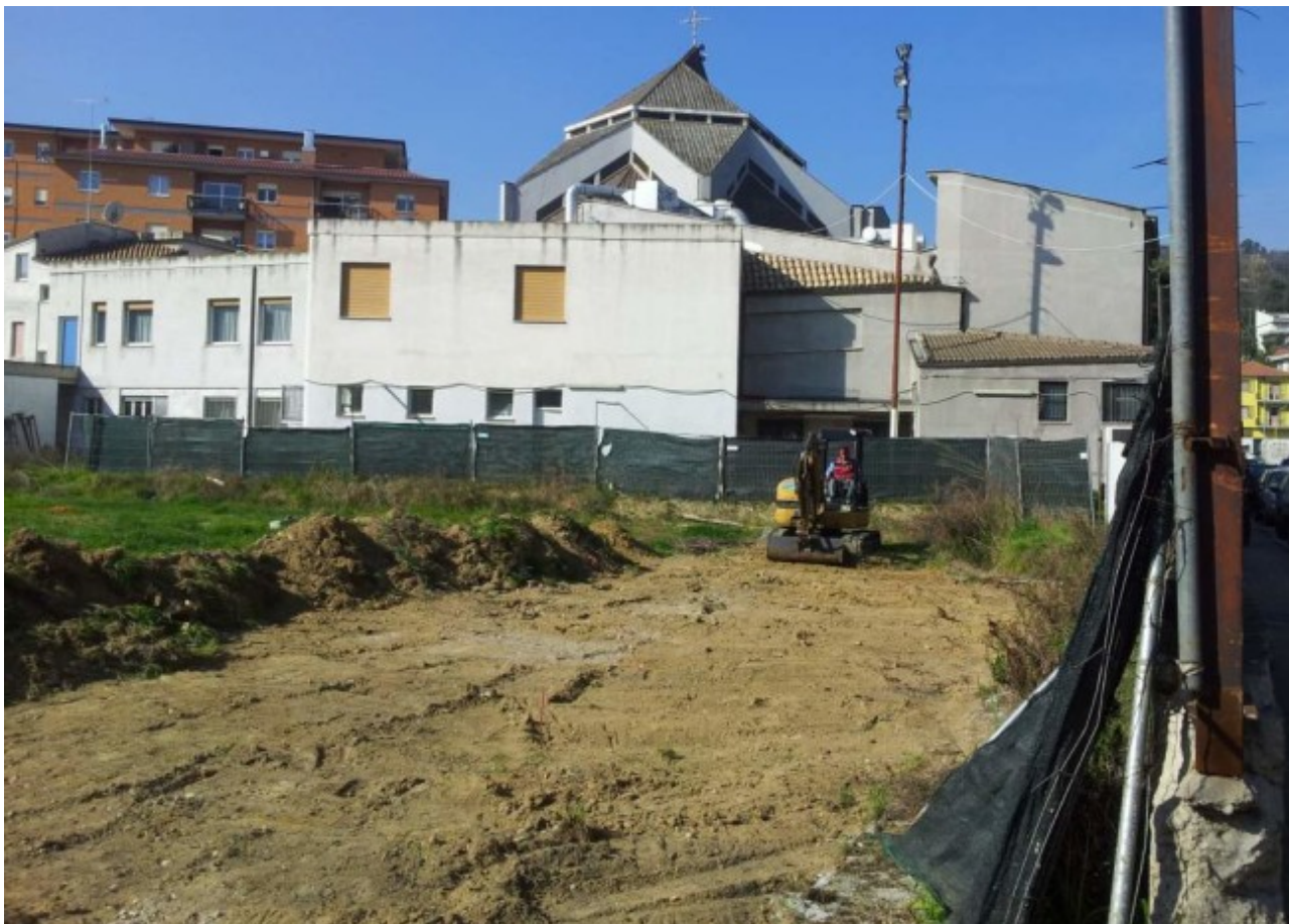
Impianto San Filippo Neri prima dei lavori
