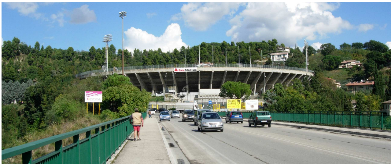
Figura 3 - Visuale della curva sud da viale constantino rozzi
