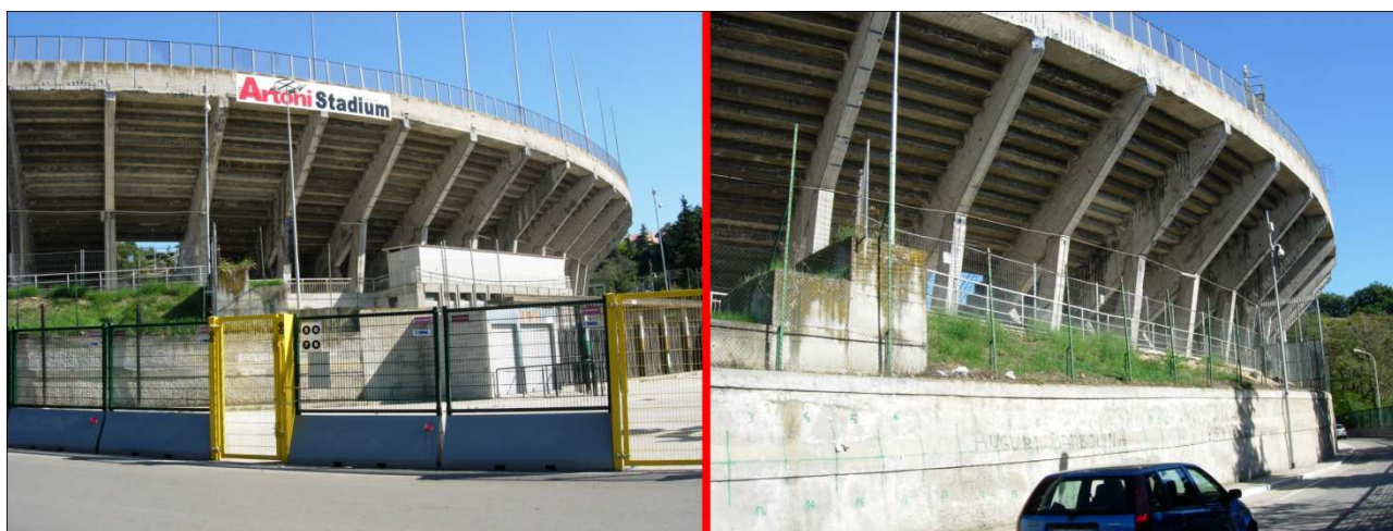
Figura 4 - Viste sulla curva sud: si possono notare i cavaletti strutturali di sostegno
