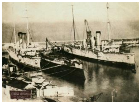
Fig. 27. Demolizione, nel porto di Gallipoli, di 3 corazzate ex austriache acquisite dall'Italia come preda bellica.
