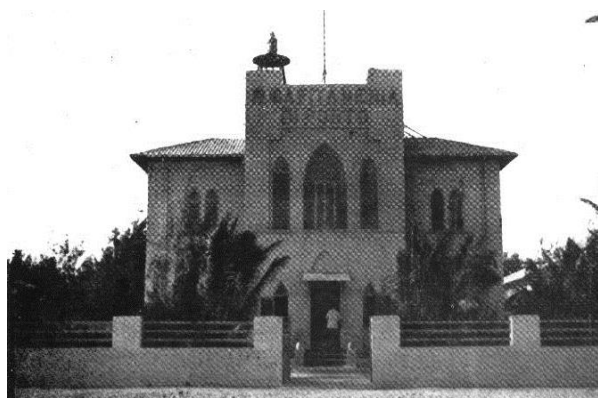
Fig. 35. La sede della Capitaneria di porto di Mogadiscio dalla quale dipendevano due uffici circondariali e 15 uffici minori.
